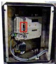
Retirez le câble Modbus du connecteur COM1 de l'IHM en utilisant un petit tournevis pour desserrer les vis de fixation, puis en tirant pour libérer le câble.
